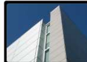
FACCIATA VENTILATA RIVESTIMENTO IN LAMIERA
