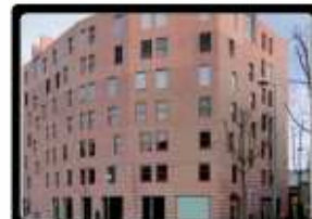
FACCIATA MASSIVA IN LATERIZIO
